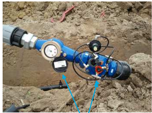
Electrovanne de régulation de pression et compteur
